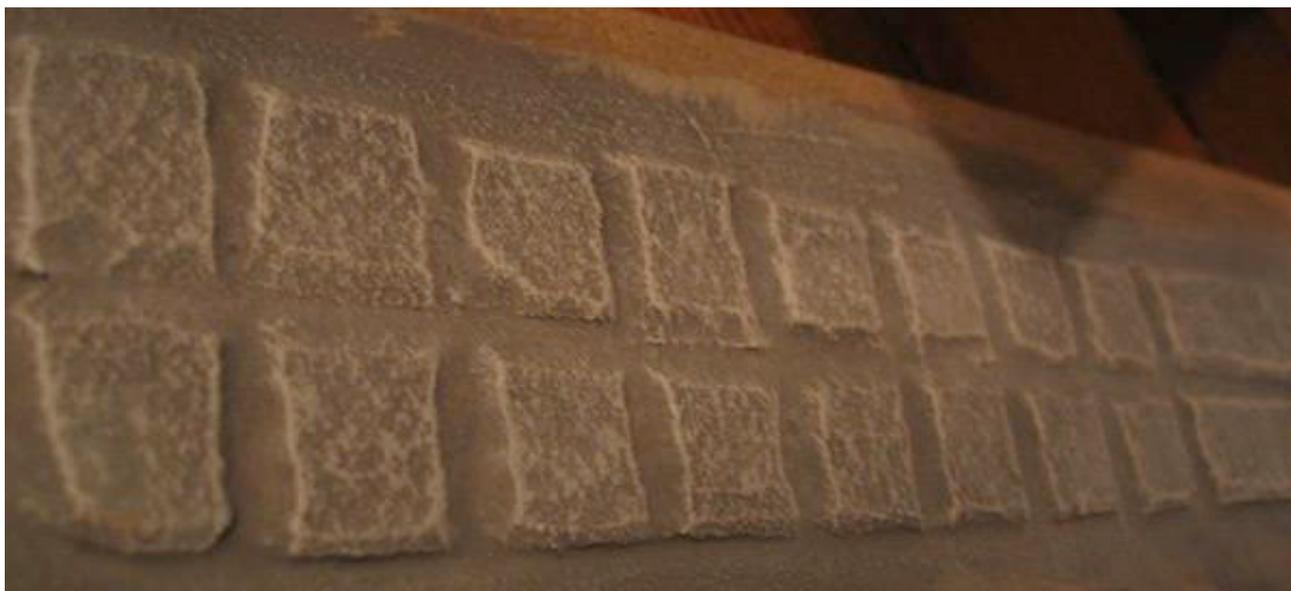
Une fois sèches, je les ai recouvertes d'une bonne couche d'enduit de bouchage pas trop dilué.
